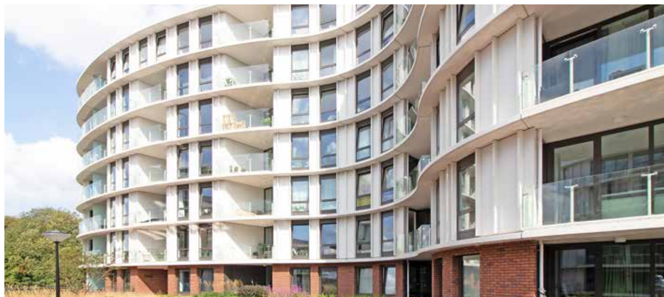
VPT Versteeg voorziet in alle witte aluminium stijlen en panelen tussen metselwerk en sierwerkbetonbanden in.
