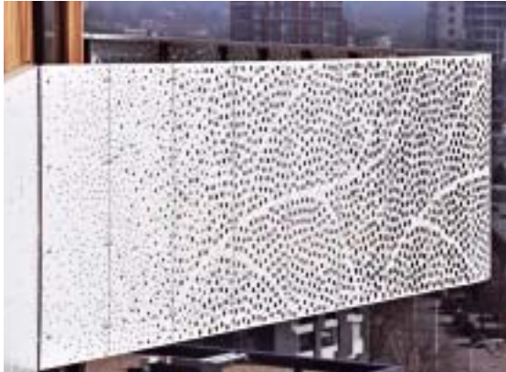
Vorgefertigt: 2 600 Aluminium-Paneele wurden individuell mit einer CNC-Fräse perforiert.
