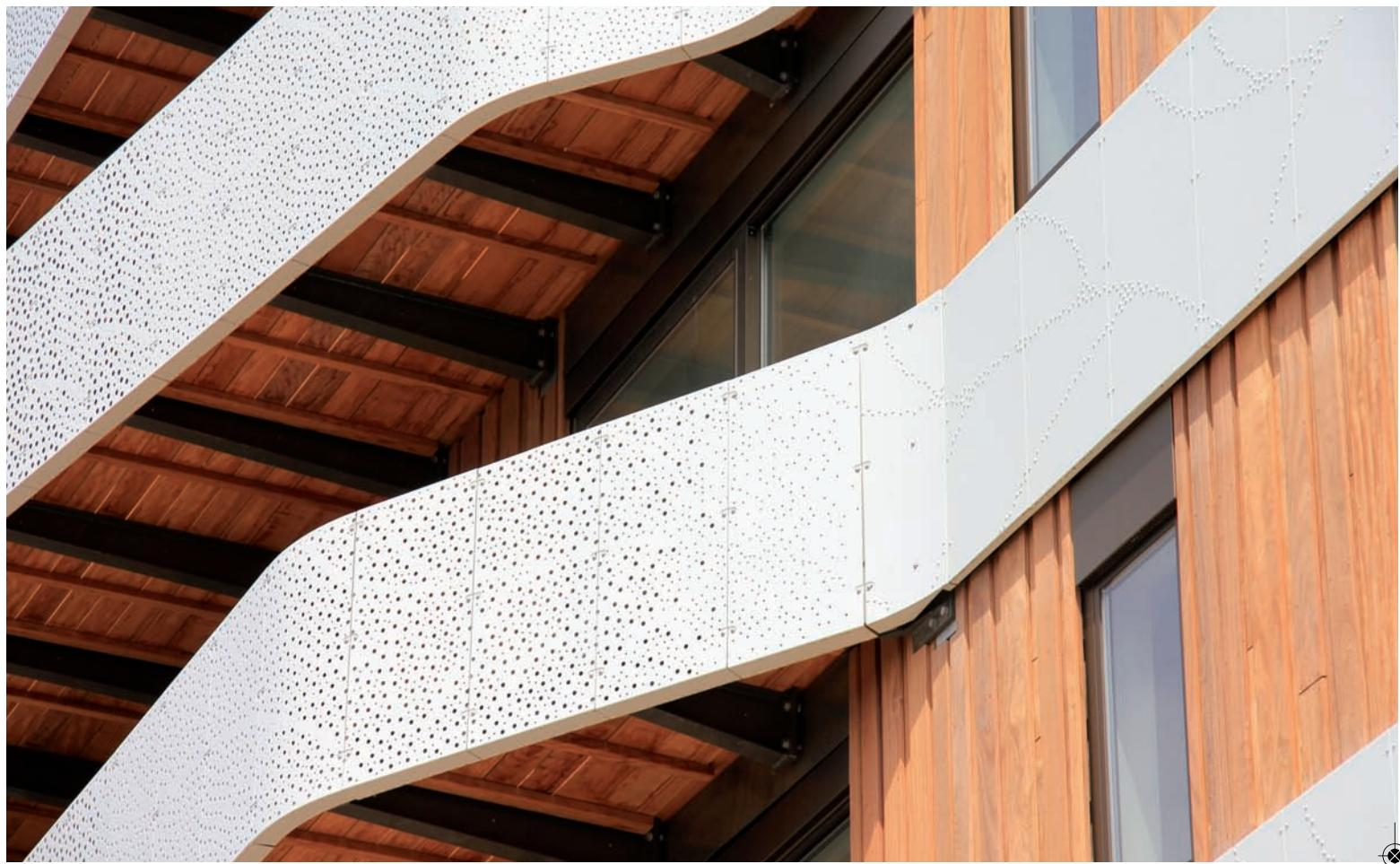
*Het grootste balkon hangt aan 14 Isokorven. De stijfheid van de staalconstructie is dermate groot dat het niet nodig was om de balkons een zeeg te geven. "We hebben er met z'n drieën op staan dansen. Dan voel je wel beweging, maar niet meer dan bij een betonnen balkon."*
