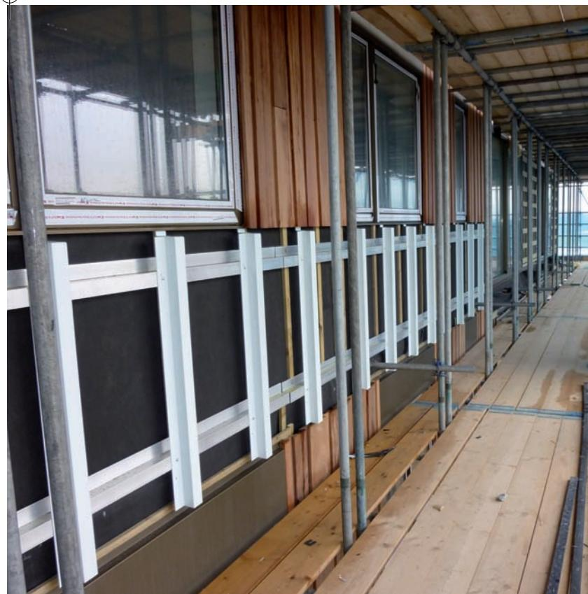
De aluminium gevelpanelen zijn gelijktijdig met de balkons aangebracht, bij het zakken van de steigers.
