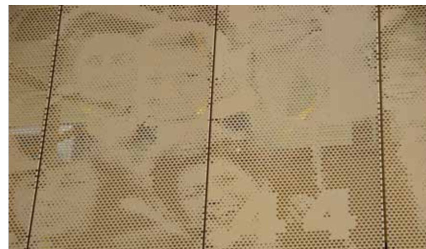
De gevelbekleding is voorzien van Art-Punch perforatie in hartjes vorm.
