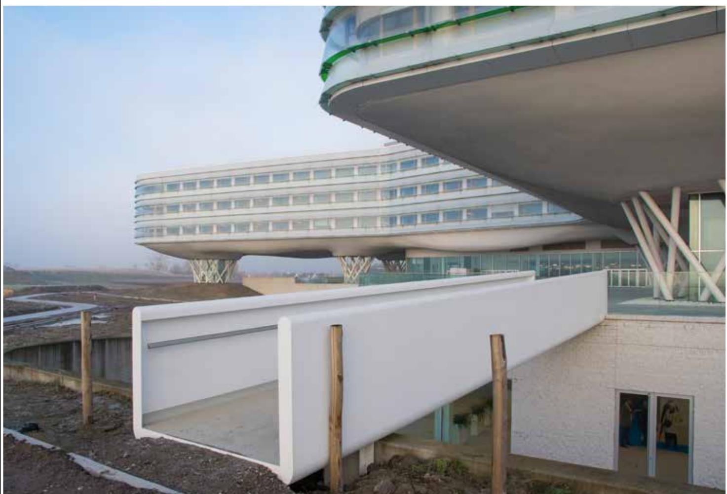
het bovenvlak werden opgebouwd aan de hand van L-vormige portieken uit HEA-profielen zodat de andere zijde van de passerelle zo kon worden ontworpen dat ze later ingevuld kon worden met de 3D gevormde beglazing. Nauwkeurigheid bij uitvoering en montage was zeer belangrijk. De stukken dienden aangevoerd met een grote kraan aangezien alles plaatsvond in een moeilijk toegankelijke gesloten patio."
