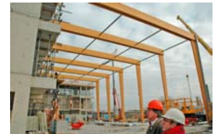
Houten spanten in aanbouw.
