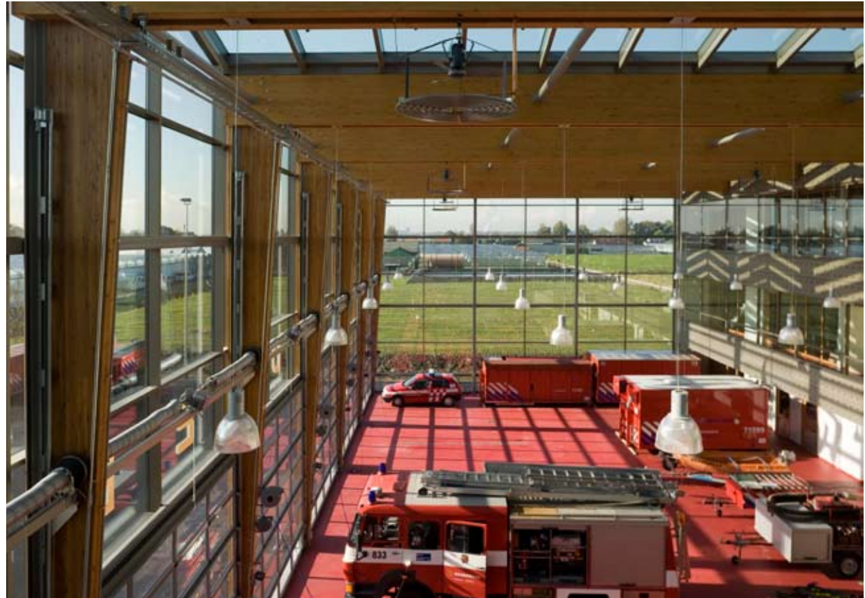
De houten spanten in de remise zijn, net als al het toegepaste hout, ook voorzien van het FSC-keurmerk.
