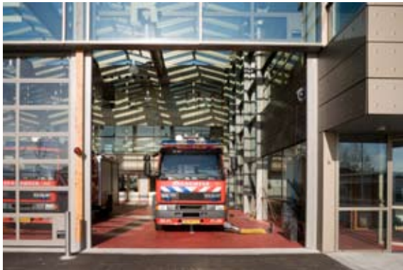
De rookgassen worden via kanalen in de vloer afgevoerd naar de rood-witte schoorsteen.
