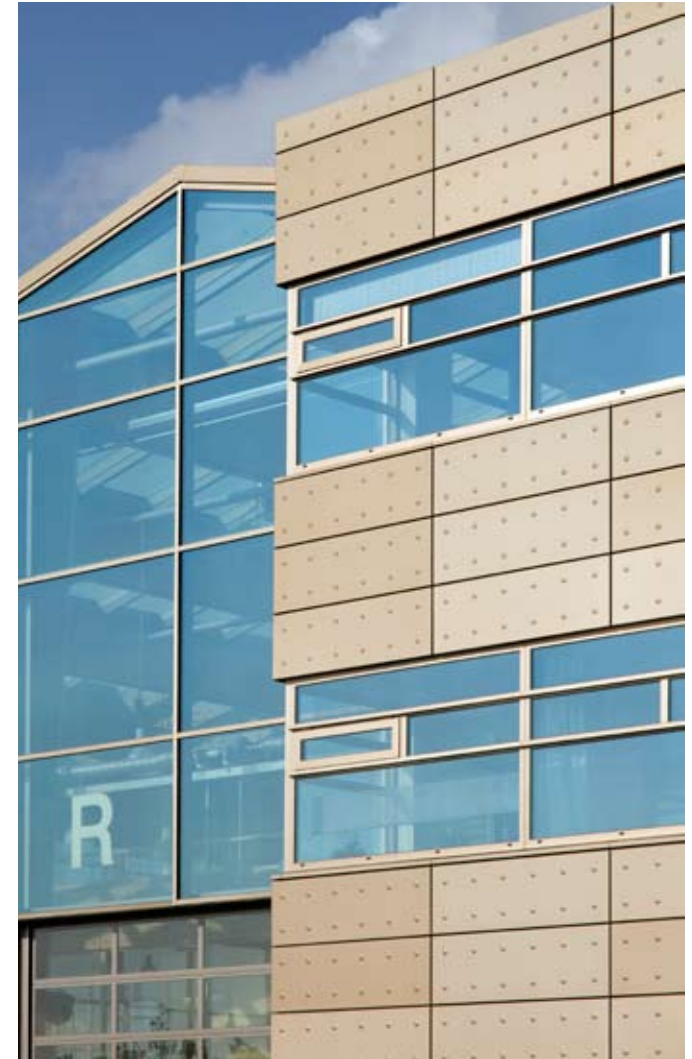
Licht bronskleurig geanodiseerde gevelpanelen met een bolvormige figuratie erin gestanst geven het gebouw een stoer uiterlijk.
