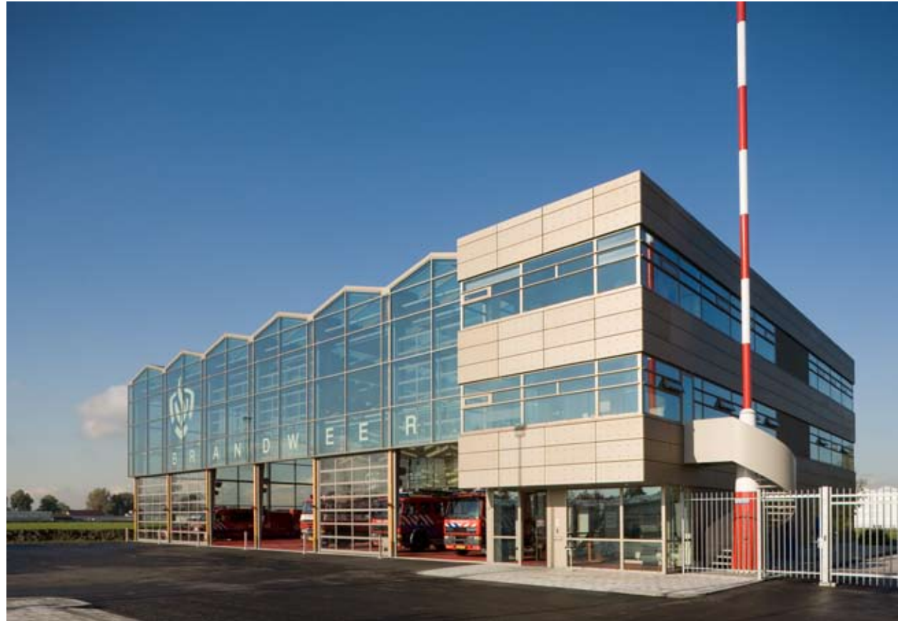
Rood-witte paal waardoor rookgassen worden afgevoerd geeft de brandweer ook vanaf afstand een zichtbare aanwezigheid.
